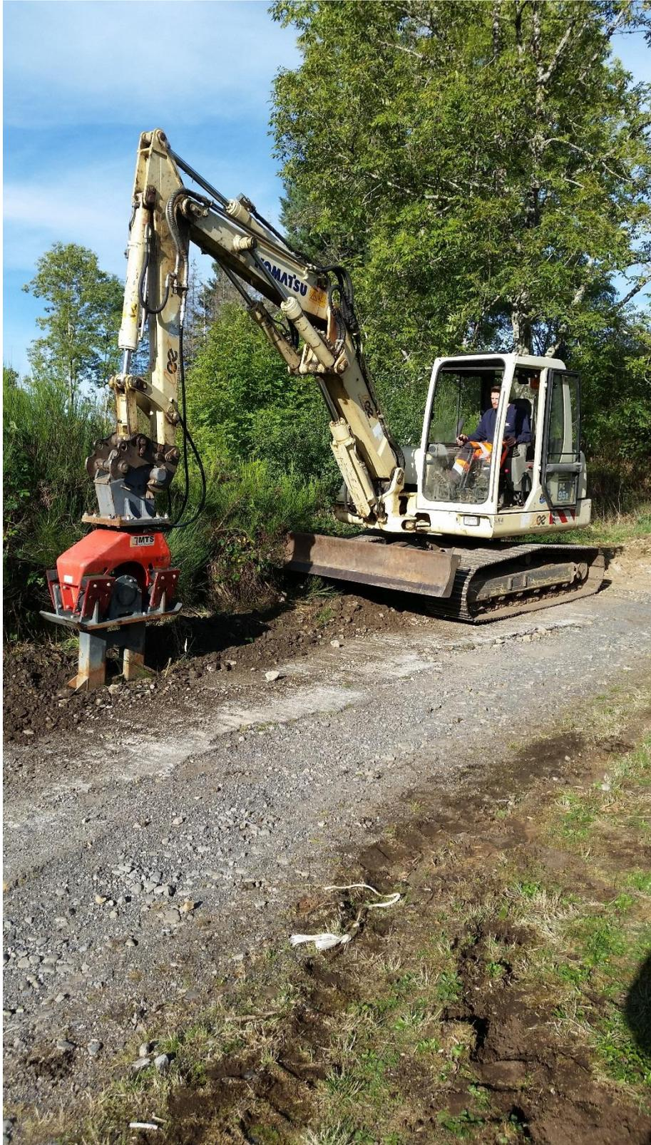
**Extension réseau BT avec technique mécanisée – trancheuse
