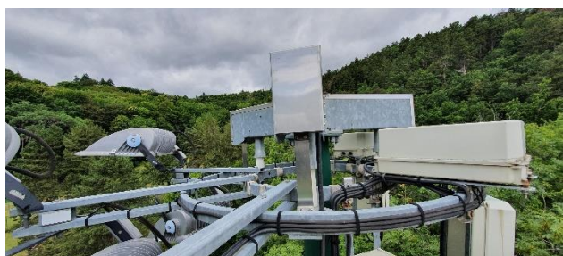
Couronne spécifique, projecteurs et appareillages à déposer
