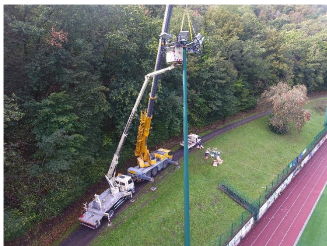
Intervention Grue 50T et nacelle 25 ml pour dépose et pose nouvelle herse + 7 projecteurs
