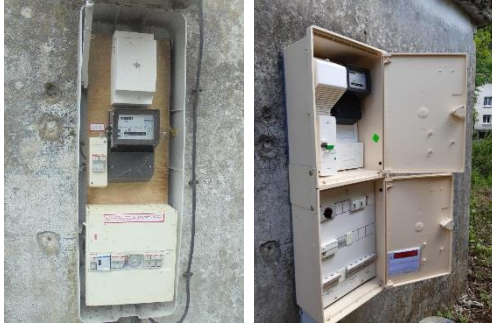
Renouvellement commande EP
