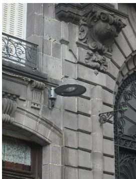
Réfection Rue Ramond
