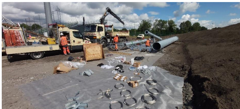
Mise en œuvre : l'Entreprise Électrique - Maitrise d'ouvrage : Clermont Auvergne Métropole / Clermont Foot 63 - Maitrise d'œuvre : EGIS
