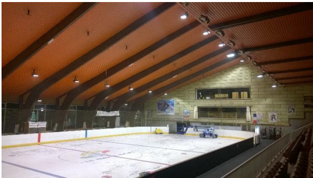
Réfection éclairage patinoire
