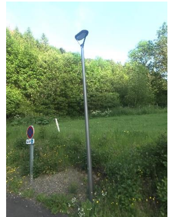
Réfection mât et lanterne centre hippique
