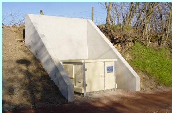
Poste de transformation avec mur de soutènement Mur en élévation en béton coulé.
