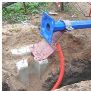
Solution retenue : trouver un appareil permettant de lever les candélabres sous les lignes BTA et HTA en toute sécurité.
