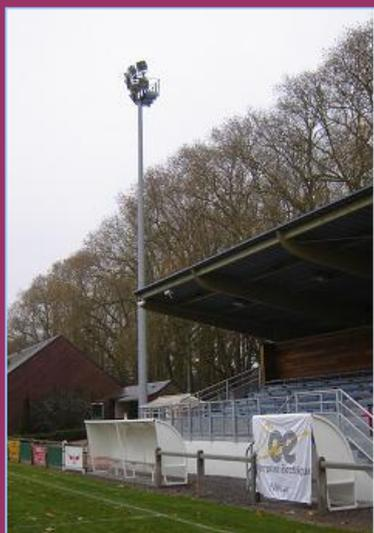
L'Entreprise Electrique a été retenue pour l'entretien et le remplacement de 32 sources lumineuses de 2000 watts (Iodure Métallique).
