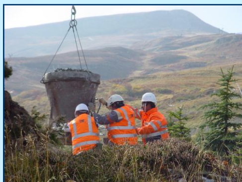
800 litres de béton !
