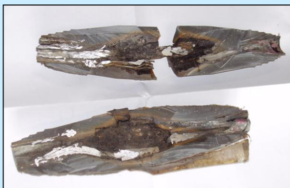
Expertise d'un court circuit sur une boîte souterraine
