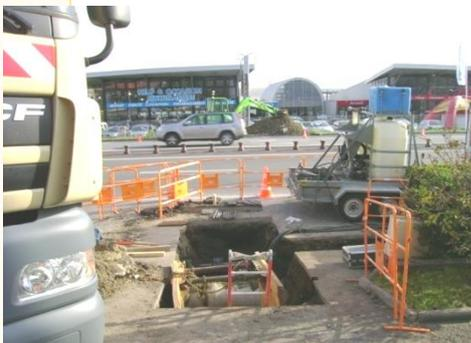
Avenue du Roussillon à Aubière l'entreprise a réalisé un forage dirigé pour la création d'un réseau de fibre optique pour le compte de Clermont Communauté Networks.
