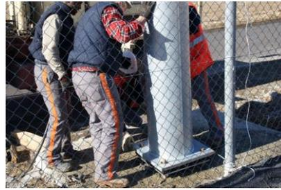
*Au sol les monteurs n'ont plus qu'à guider le pied du pylône dans son fourreau dont les fondations coulées bien avant ont nécessité de nombreux mètres cubes de béton et plus de trois semaines de séchage pour solidifier le massif.*
