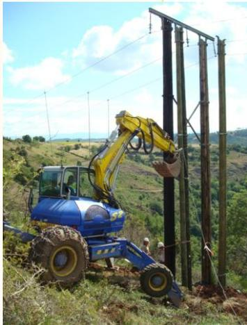
Lors d'un écobuage mal contrôlé, le feu a pris sur un portique bois jumelé HTA. Les flammes montèrent jusqu'en haut fragilisant les poteaux.
