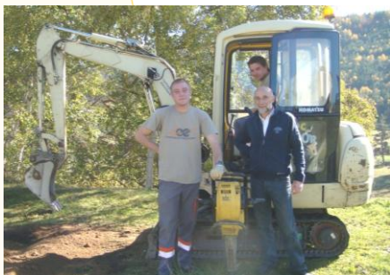
Chantier situé sur la Commune de Fau de Peyre
