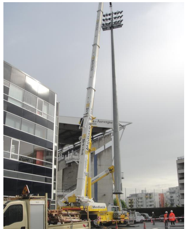
Dépose du mât de 36 m avec la grue de 200 T
