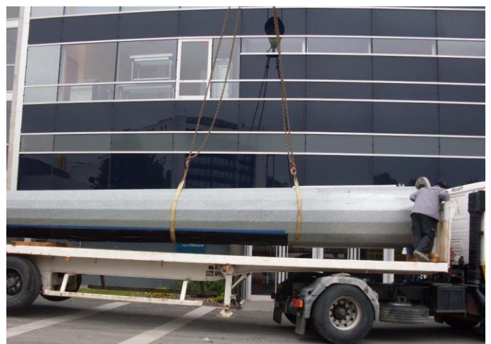
Chargement et transport sur semi-remorque des 3 éléments du mât
