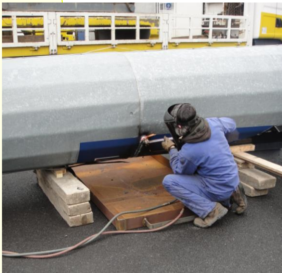
Découpe des mâts au chalumeau
