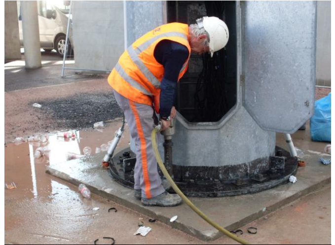
Déboulonnage du pied des mâts au pistolet pneumatique : 24 écrous de 55 mm
