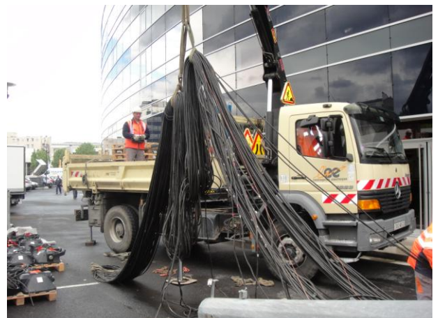
Dépose des 40 câbles d'alimentation H07 RNF 2X6 mm 2
