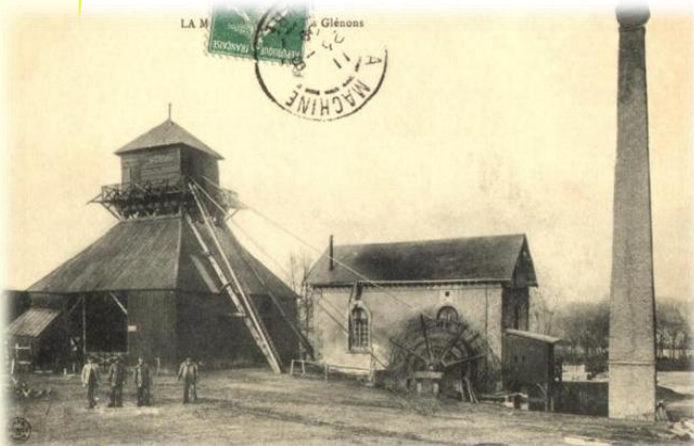
Le chevalement du puits des Glénons en bois à l'origine
