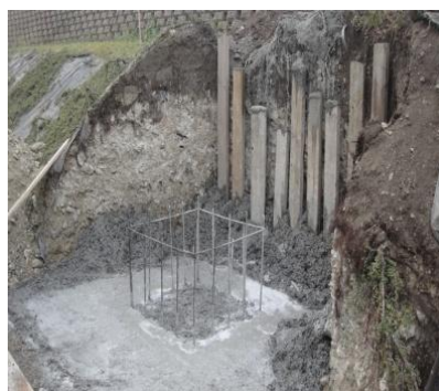
Massifs pour mâts avec semelle enterrée et cheminée (Environ 50m 3 de béton avec ferrailage pour les 4 massifs)
