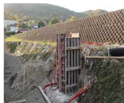
Massifs pour mâts avec semelle enterrée et cheminée (Environ 50m 3 de béton avec ferrailage pour les 4 massifs)
