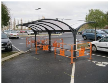
Abri-Vélos - Parking Centre d'Affaires du Zénith - Cournon d'Auvergne
