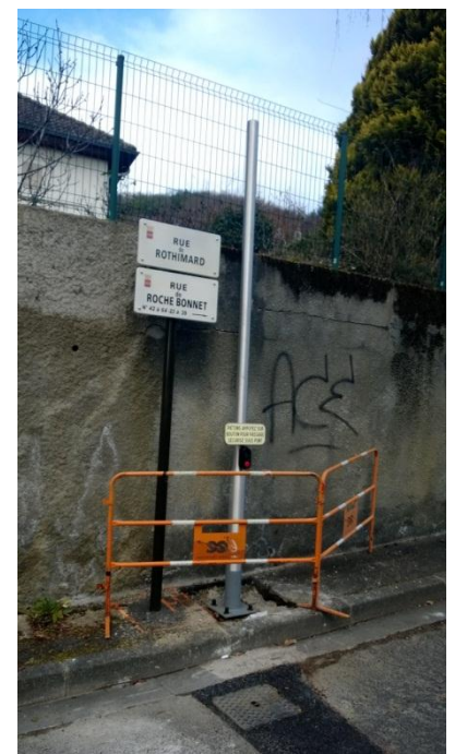
Bouton poussoir spécifique pour piéton avec panneau d'information « Piétons appuyer pour passage sécurisé sous pont »
