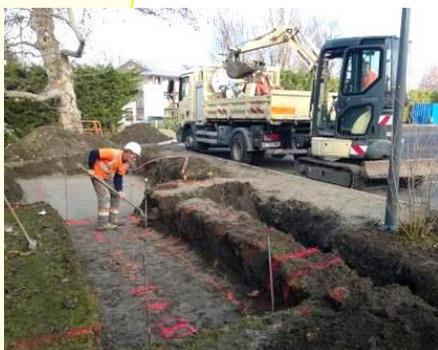
Le principe est le suivant : 8 bornes de recharge, pilotées par 4 superchargeurs (ordinateurs de commande), le tout alimenté par un poste de transformation 800 KVA dédié. Les terrassements ont été conséquents et la précision importante, notamment parce que les superchargeurs ne tolèrent que très peu de marge de manœuvre pour l'entrée des gaines. Notre équipe de génie civil Michel et Doudou (*Michel MATHURIN et Roland CORDIER*) s'en sont occupés d'une main de maître.
