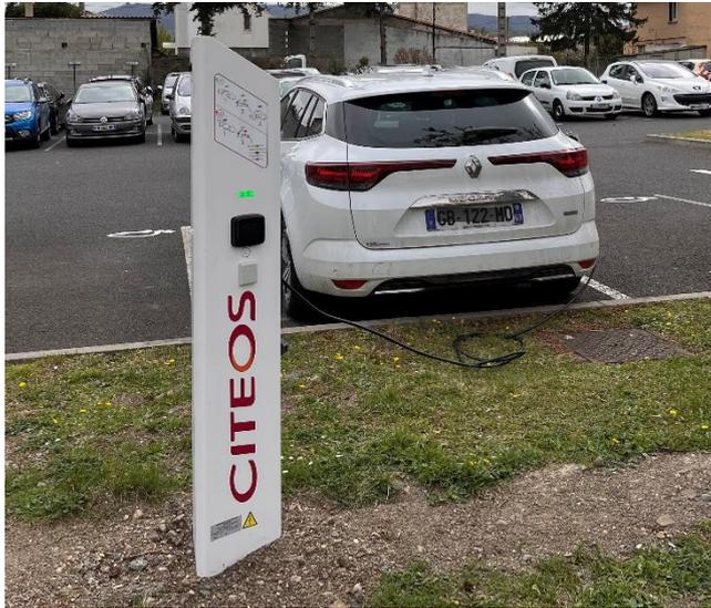
Sur le site de Clermont-Ferrand, c'est sept points de charge AC 22kVA installés et un point de charge DC 24kW. Une supervision est mise en place pour le suivi et la maintenance des bornes, ainsi qu'un pilotage énergétique pour respecter la puissance disponible sur le site et permettre son évolution.
