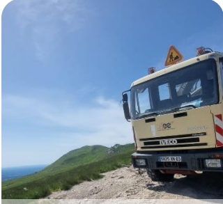
Sondages pour détection HTA Super Besse / Mont-Dore
