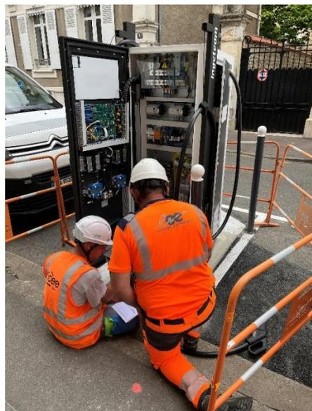
Dans le cadre d'un AMI (Avis Manifestation d'Intérêt) entre la ville de Nevers, le SIEEN et Easy Charge, l'Entreprise Electrique Decize réalise l'installation de 8 bornes IRVE 120kW sur la ville de Nevers.
